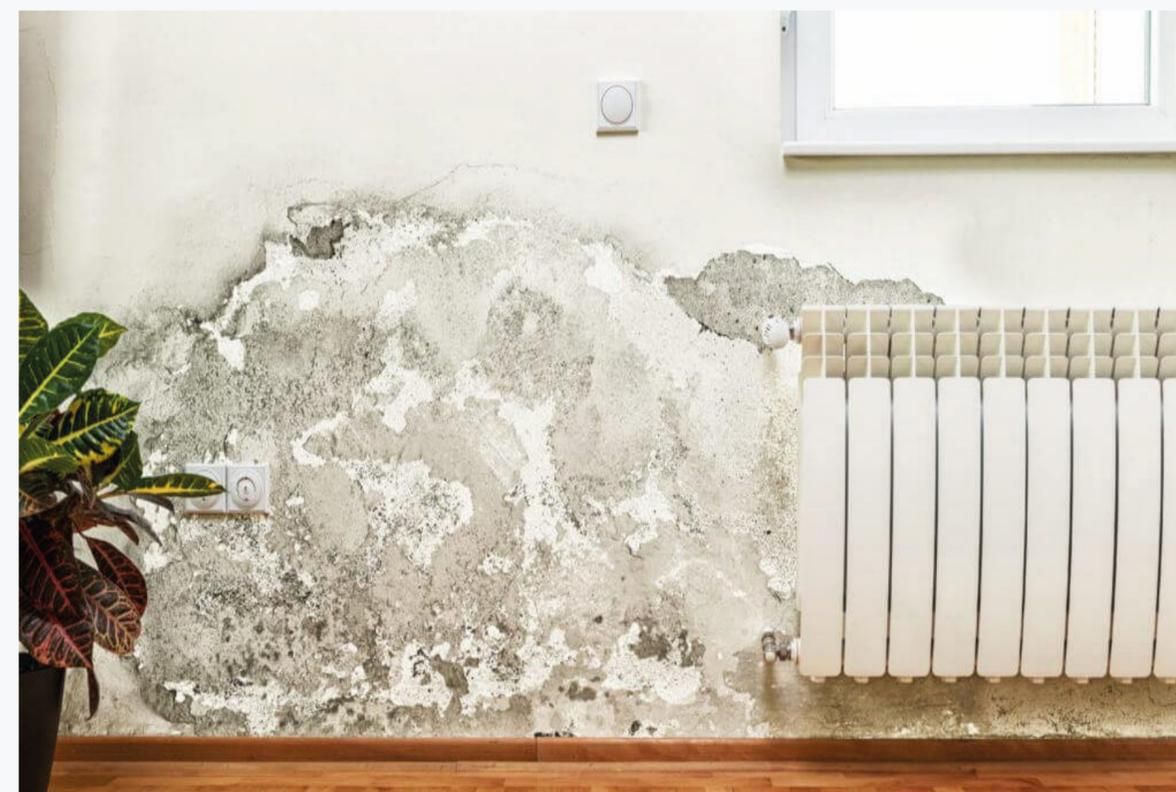
Parede com umidade na parte de baixo, vindo do solo.
